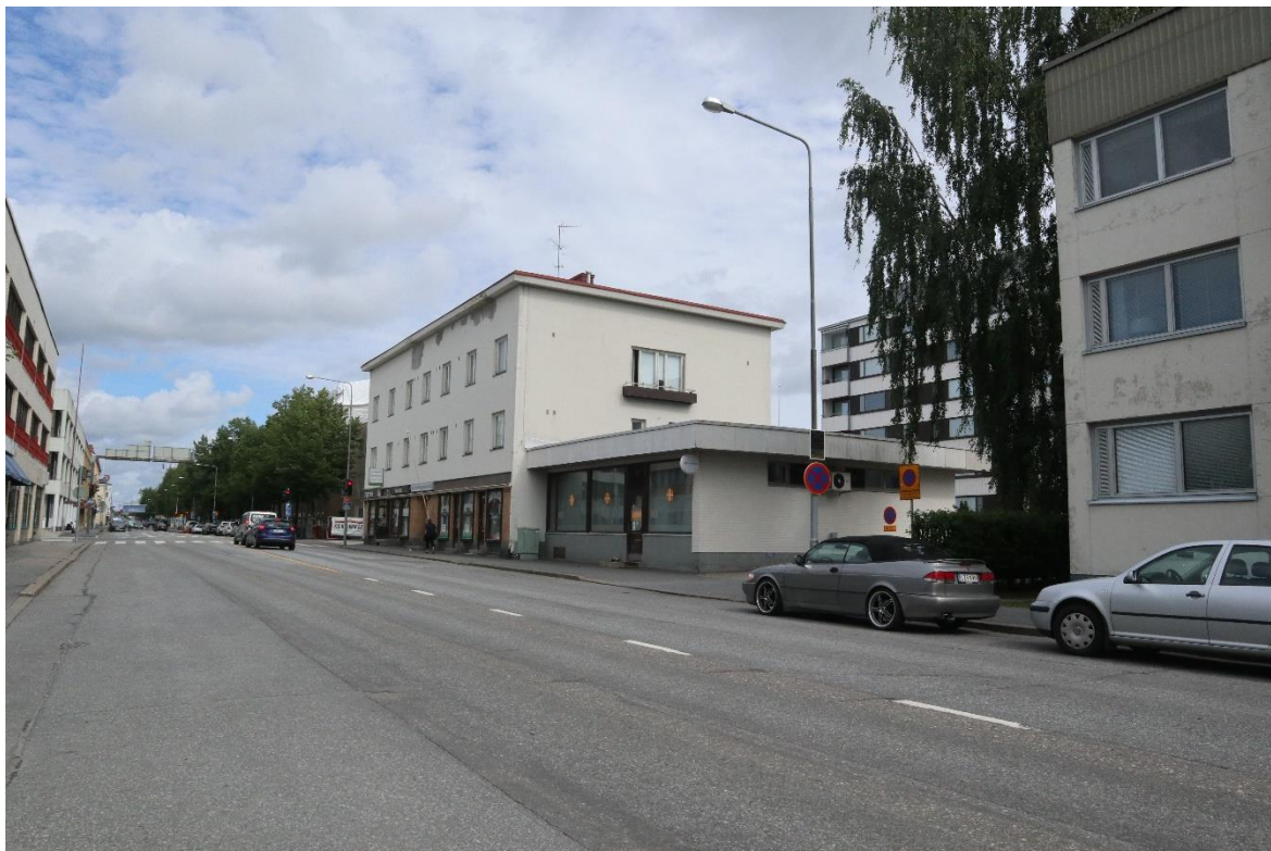
Kuva 5. Maaherrankatu 7 ja sen eteläpään myöhemmin rakennettu liikesiipi kuvattuna elokuussa 2020.
